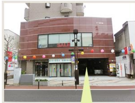
ニーズビル 駐車場入口
